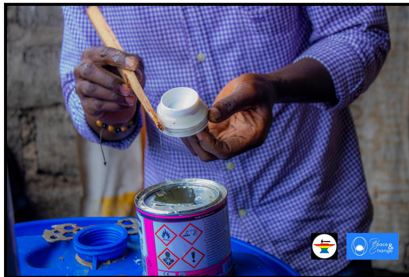
Colle PVC pour étanchéifier l'orifice principal - cc by SA Peace and Change asbl.
