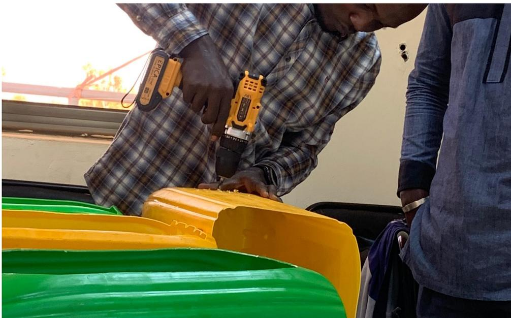
Le bidon qui servira de réservoir est coupé par la tête et ensuite avec une perceuse, un trou est créé vers le bas pour permettre l'insertion d'un robinet .
