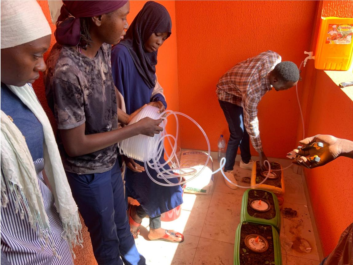
Les bacs et le réservoir sont placés dans l'espace qui était prévu pour le projet de culture hors sol avant de faire les raccordements avec le tuyau.
