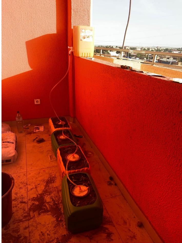
L'image ci-dessus présente le raccordement de tous les pots au réservoir à partir des tuyaux.
